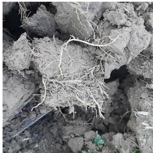
Figure 61. Exemple de motte de terre compacte dans la modalité SD. Les racines peinent à traverser le sol
