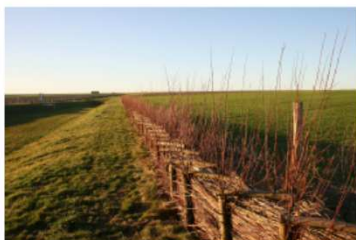
④ En protection rapprochée d'un ouvrage hydraulique
